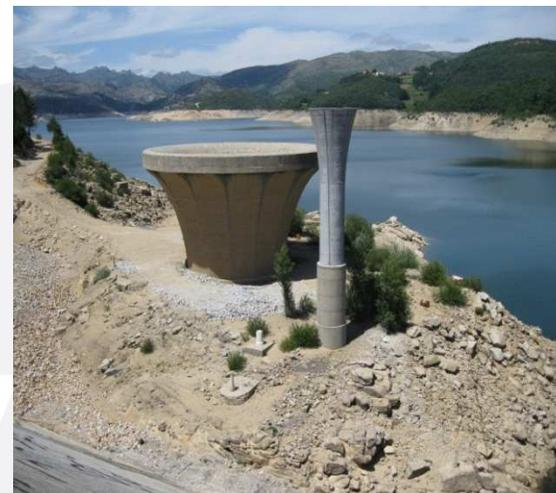
**Paradela – descarregador original em poço e descarregador auxiliar recente**
