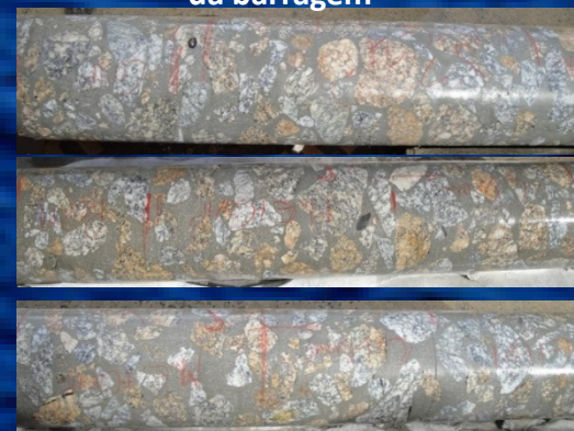
Amostras de BPCA retiradas da barragem
