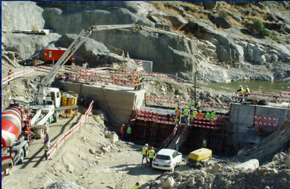
1 - Vista de montante durante a construção
