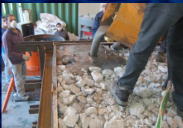
2 - Colocação da argamassa
