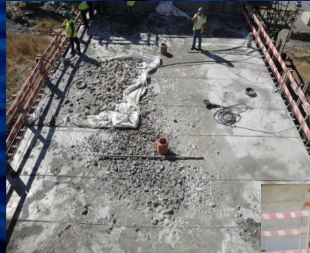
Aspecto final da camada com geotêxtil
