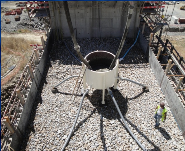
Dispositivo p/ colocação da argamassa
