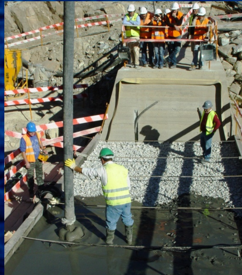
2 - Vista durante a construção (colocação da argamassa)
