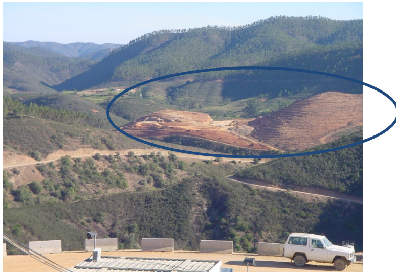
Vista geral de uma das áreas de empréstimo de materiais de construção da barragem de Odelouca (Outubro de 2002)
