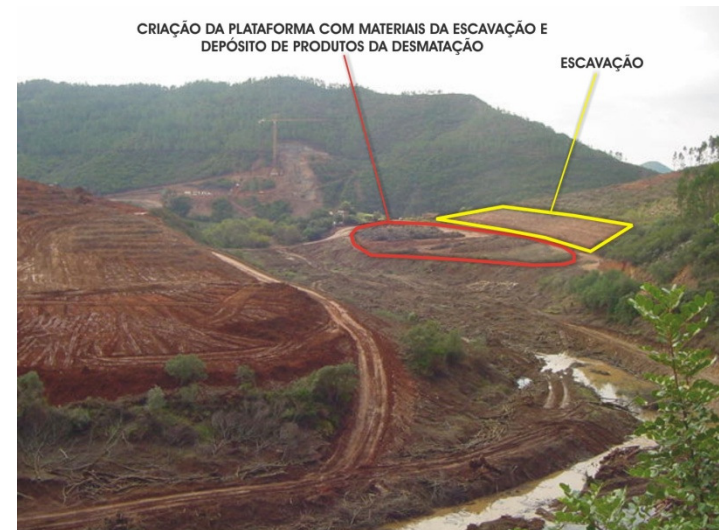
Área de empréstimo de materiais para o núcleo (Outubro de 2002)
