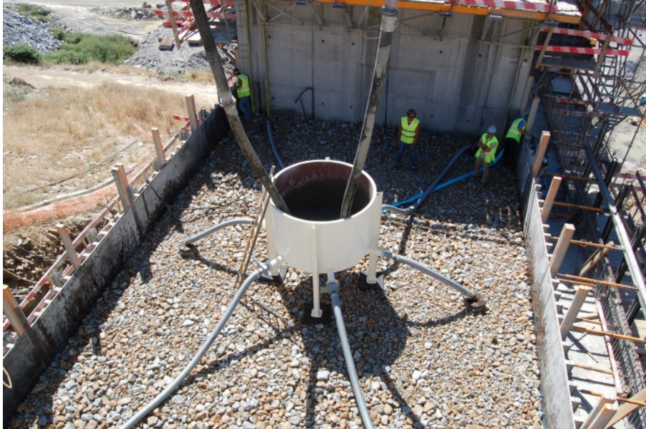
Início da aplicação da argamassa com os agregados pré-colocados
