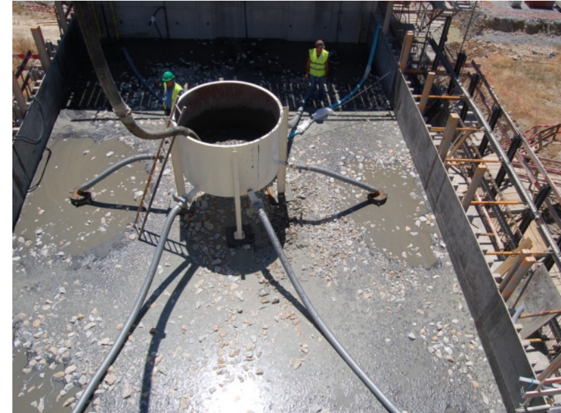
Fim da colocação da argamassa
