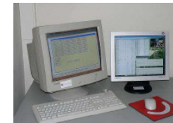
Unidade de controlo
