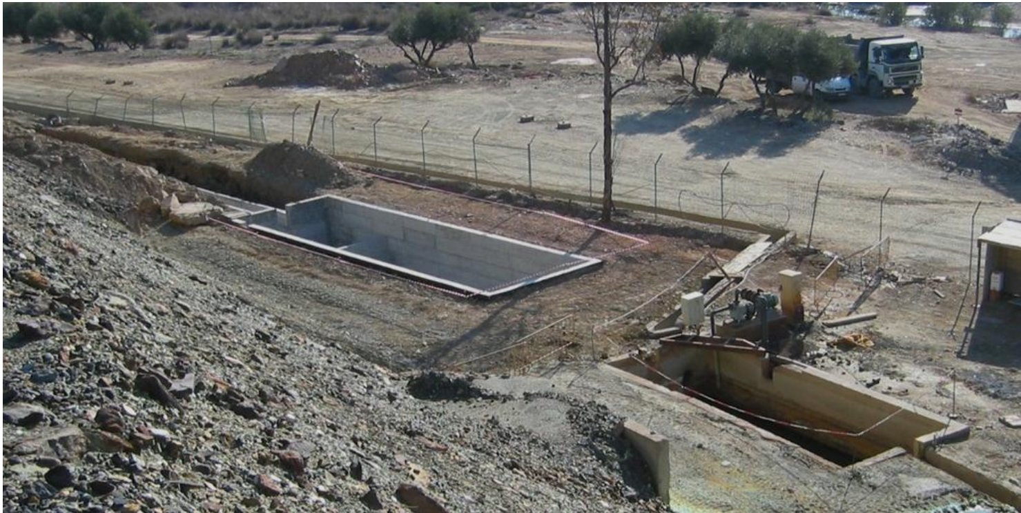
Tanques na base da E1A
