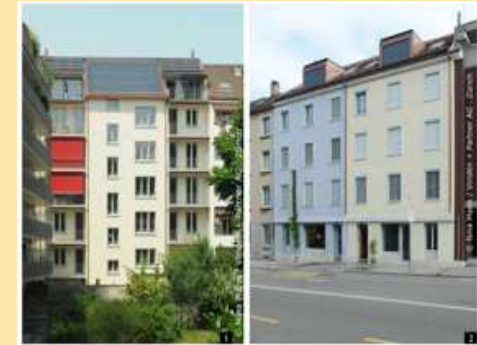
Bâtiment à énergie positive réalisé dans le quartier à haute densité d'habitation de Matthäus à Bâle (Feldbergstrasse 4-6, bâtiment de 1896, inscrit au patrimoine, combinaison d'une sur isolation thermique, d'implantation de capteurs solaires thermiques et photovoltaïques et de mise en place de réservoirs saisonniers de chaleur dans l'immeuble) (Prix Solaire Suisse 2009).
