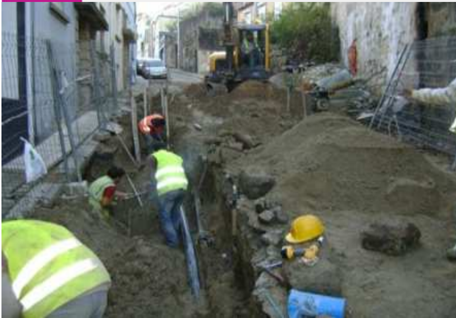
Técnica com abertura de vala
