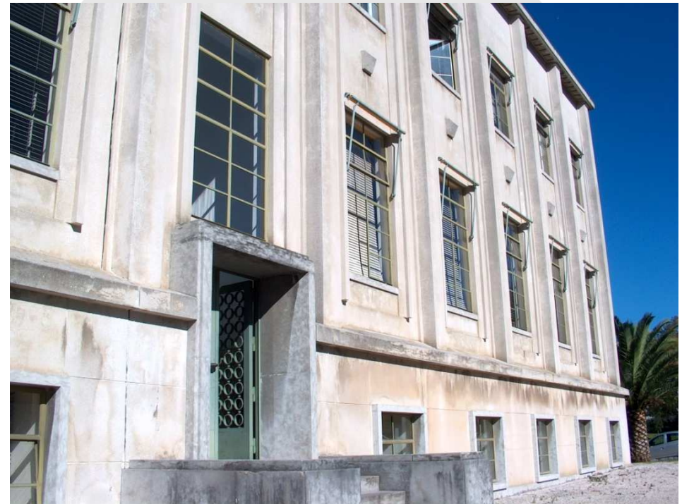
Edifício Principal do LNEC, Lisboa, 1956
