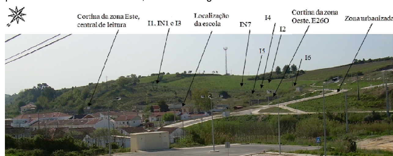
Figura 3 – Aspeto global dos taludes adjacentes à Escola, sua localização e zona urbanizada. Identificação das zonas instrumentadas e alguns tubos de inclinómetro
