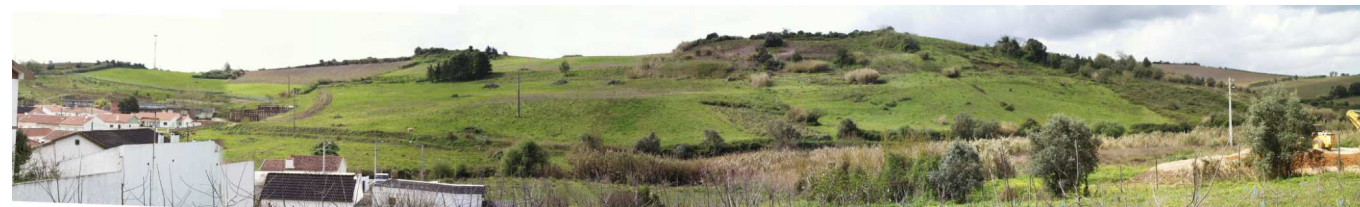
Figura 1 – Aspeto visual dos taludes
