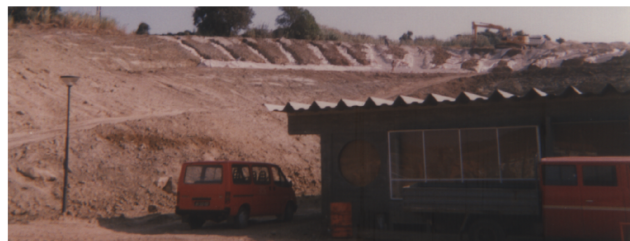
Figura 2 – Estabilização dos taludes: trincheiras, transversais e longitudinais, preenchidas com brita e areia, envolvidas em geotextil
