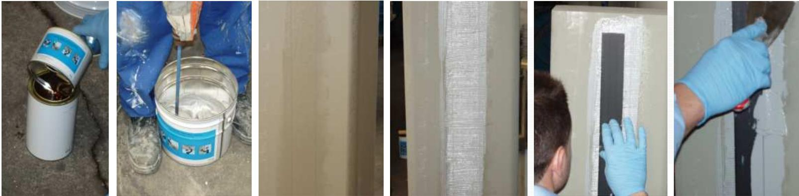
Banda ou lâmina com reforço unidireccional, que é colado sobre a superfície do elemento estrutural, utilizando uma cola, geralmente de natureza epoxídica.
