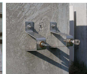
OXIDAÇÃO DAS PEÇAS METÁLICAS
