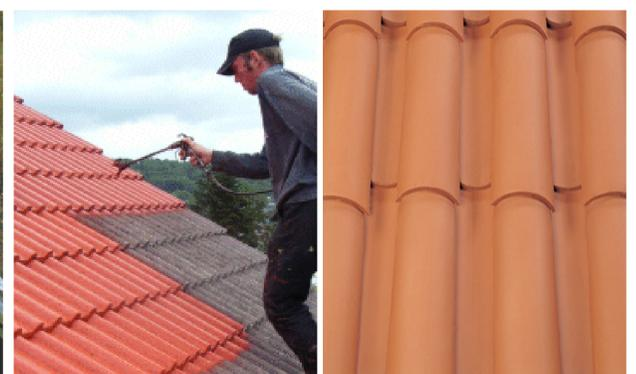
Fig. 3 – Exemplos de aplicação de produto refletante em cobertura com telha e de telhas cerâmicas de elevada refletância
