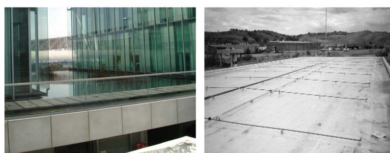
Fig. 4 - Arrefecimento evaporativo por espelhos de água ou por micro-aspersão
