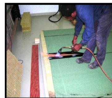
Fig. 4 – Soldadura numa junta de sobreposição com chama de maçarico
