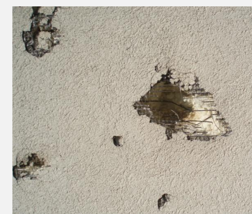
Figura 3 – Problemas de resistência ao impacto
