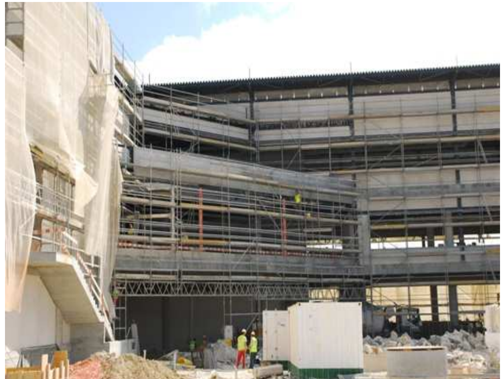
Construção do cais norte do aeroporto de Lisboa
