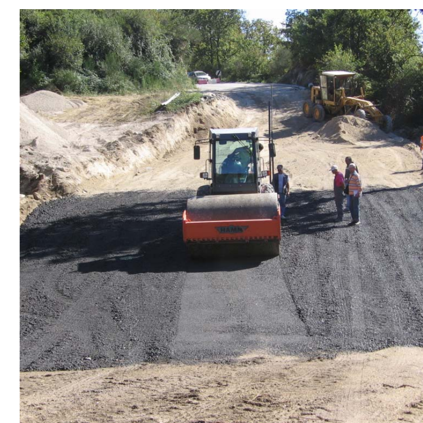
Figura 4. Construção de trecho experimental na EN 311 com escórias de aciaria
