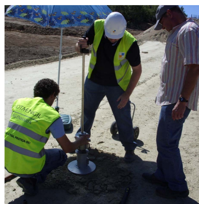
Figura 5. Controle de qualidade de camada construída no D. Interior com finos de pedra
