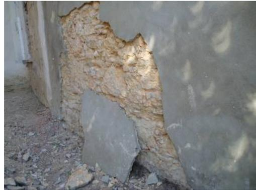
Figura 2: Destacamento de um reboco de cimento sobre um suporte antigo.
