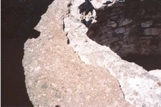
Figura 1: Revestimento antigo onde (época romana) é visível a aplicação da argamassa de cal em várias camadas
