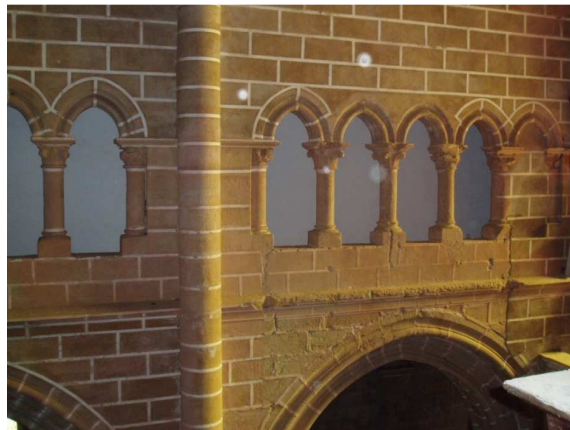
Fig. 2 – Perda de coesão e erosão
