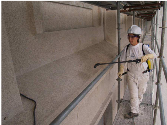
Fig. 5 – Aplicação de consolidante em obra por pulverização
