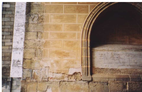
Fig. 4 – Destacamento entre camadas
