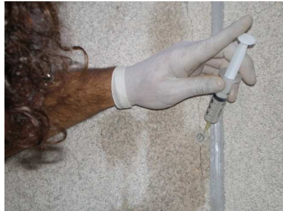
Fig. 6 – Aplicação de grout em obra por injeção
