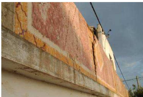
Fig. 3 – Destacamento do suporte
