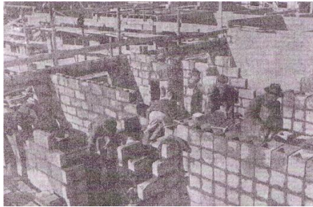
Figura 5: "Casas de renda económica, execução de alvenarias de blocos de betão", in, LOBATO, Luís Guimarães – A Experiência de Alvalade. Técnica . Lisboa: IST, nº209-210, (Fevereiro-Março, 1951).p.334.
