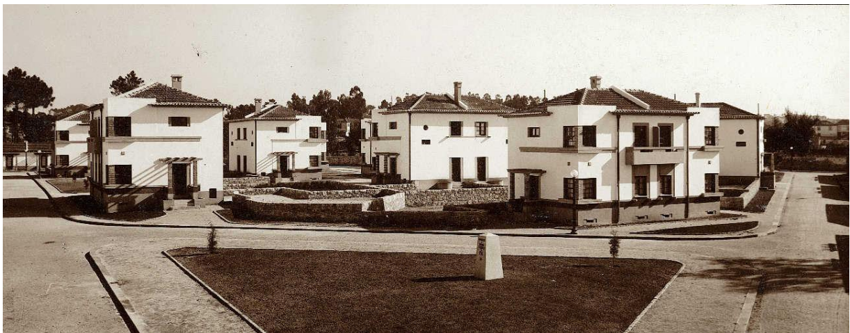
Figura 10: [Rogério dos Santos Azevedo], Bairro de Casas Económicas do Ameal, Início Inauguração 1938, Freguesia de Paranhos, Porto, in, Bairro de casas económicas do Amial / Bairro de casas económicas da Telheira , nº IPA PT011312100106
