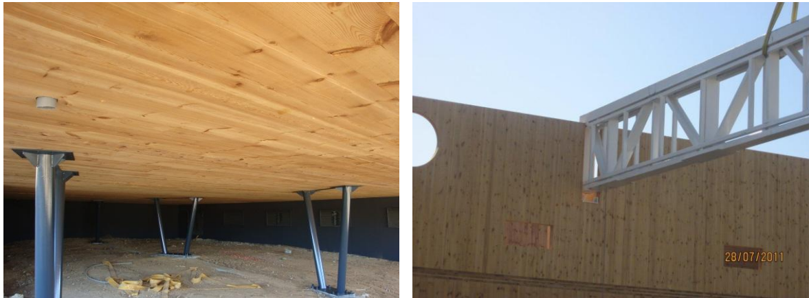
Figura 1: Imagens alusivas à laje fungiforme e ao apoio das asnas metálicas.
