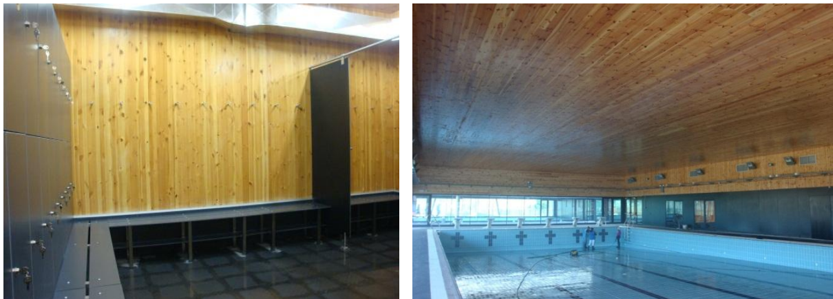
Figura 2: Imagens alusivas aos painéis X-lam com face à vista.
